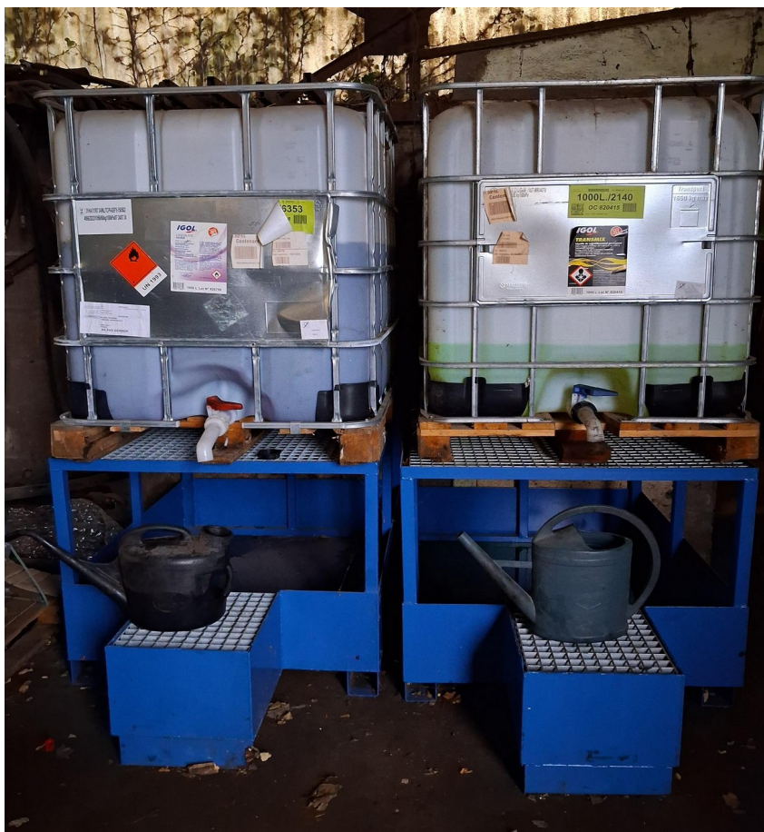
Photographie de l'action corrective : cuves sur rétentions
